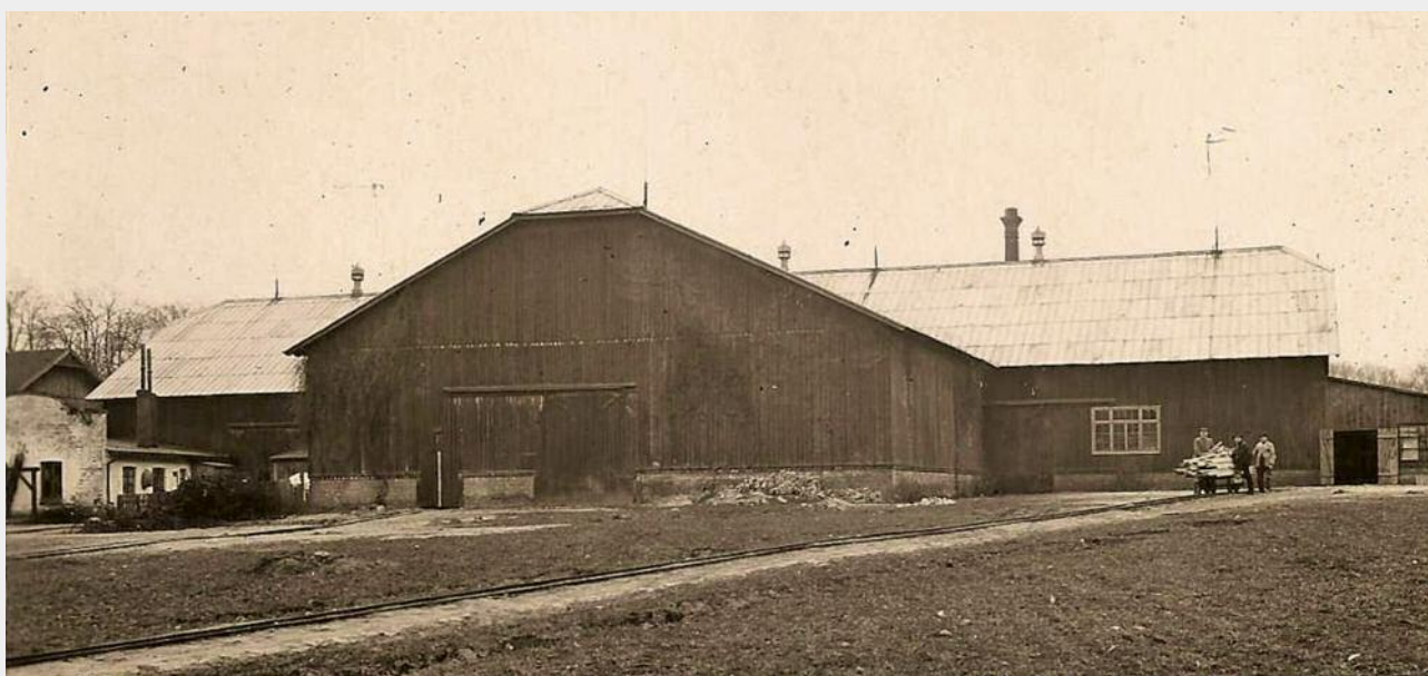
1924: Gründungsraum. Ehemals Kuhstall a. d. Volkshausgelände.
